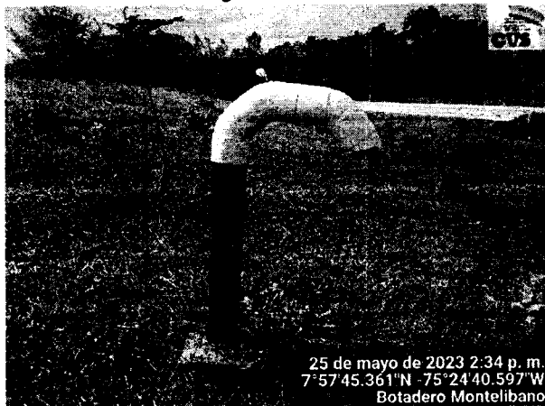
Foto 7. Chimenea de desfogue en el predio
