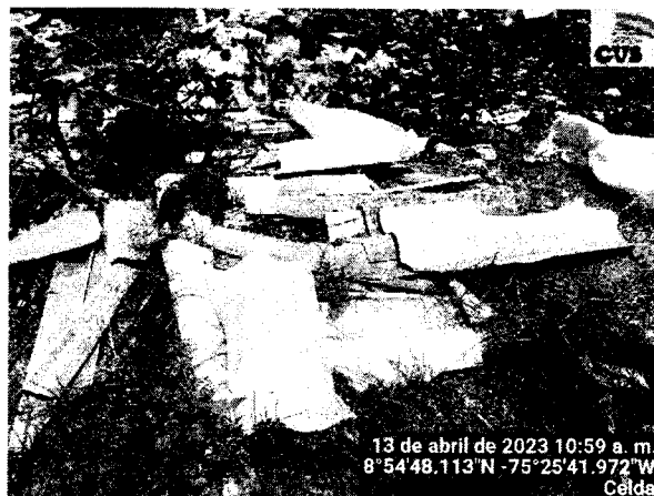
Foto 6. Disposición de residuos sólidos RCD en el sitio.
