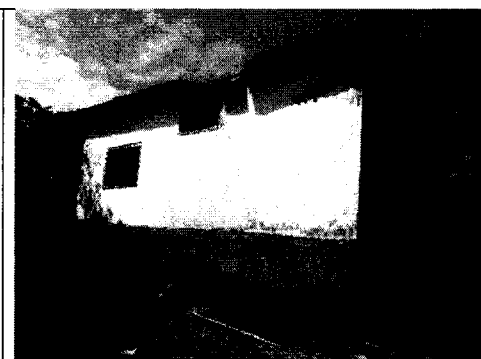
ESTACION DE BOMBEO
