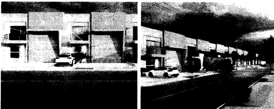
Fuente: Sitio Web https://inmobiliaria.kayros.in/inmueble/lotes-para-bodega-via-monteria-planeta-rica/ , Fecha de consulta 24/03/2023
