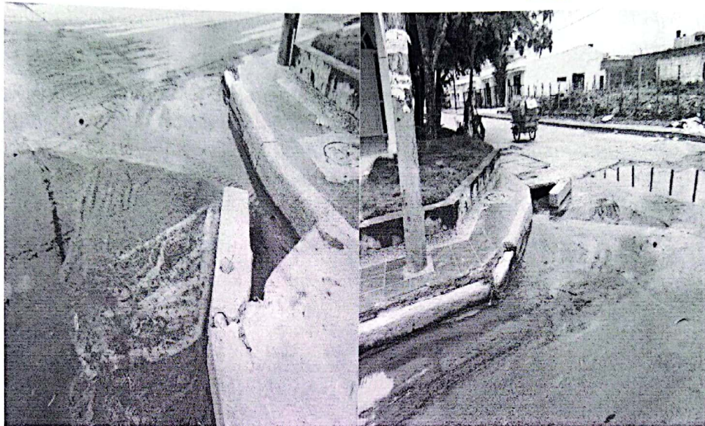
Canal de drenaje de aguas lluvias
