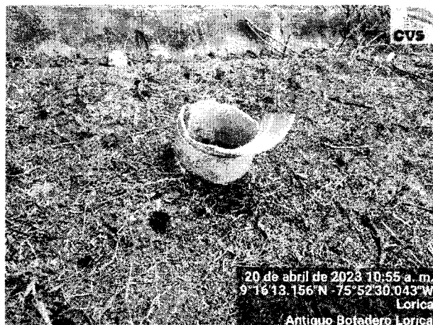
Foto 10. Restos de chimenea de desfogue en el sitio
