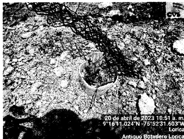
Foto 14. Vestigio de chimenea de desfogue
