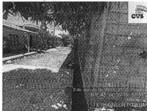
Foto 12. Mejoramiento del acostado de la pared.
