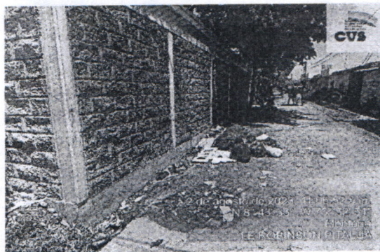
Foto 1. Aspecto general del sitio.
