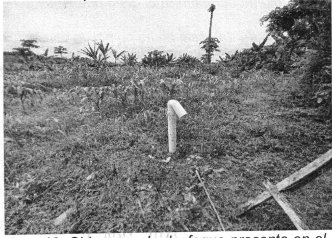
Foto 10. Chimenea de desfogue presente en el sitio.
