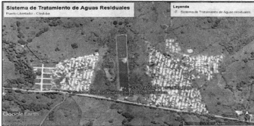
Imagen 1. Sistema de Tratamiento de Aguas Residuales
