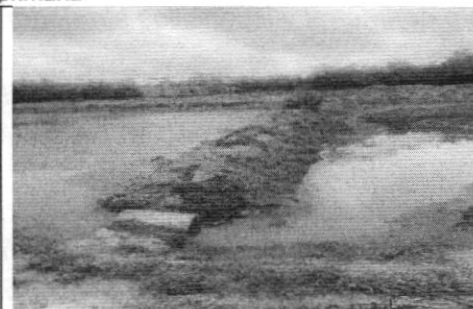
Talud y estructura de interconexión entre las lagunas
