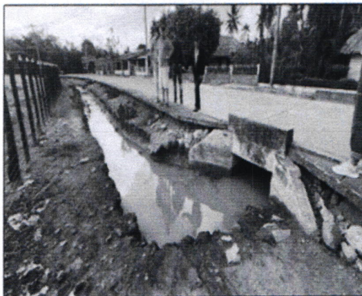
Fotos 1 y 2. Véase usillo con agua represada en canal de tierra paralelo a la vía pavimentada.
