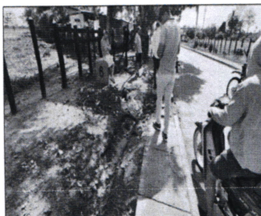
Fotos 5 y 6. Punto hasta donde llegan las aguas de escorrentías mediante el canal en tierra paralelo a la vía. En el tramo final se observa relleno y taponamiento del canal con material arenoso.
