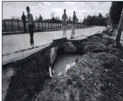
Fotos 1 y 2. Véase usillo con agua represada en canal de tierra paralelo a la vía pavimentada.
