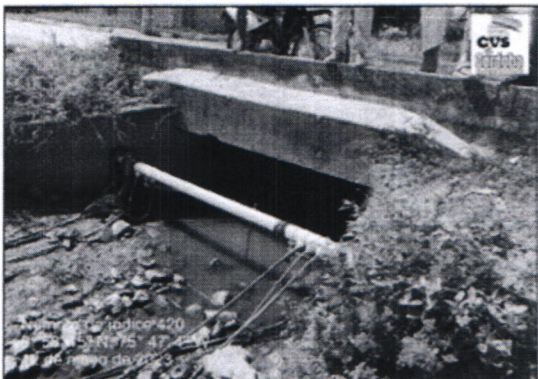
Fotos 11 y 12. Canal de drenaje en el sector San Isidro que tributa a la Ciénaga Grande de Lórica; según la comunidad, es en este canal donde presuntamente deberían reposar las aguas fluviales provenientes del corregimiento Puerto Nuevo. Se observa usillo que, según la comunidad, era el que descargaba las aguas de escorrentía que venía en el canal en tierra desde el sector de Puerto Nuevo.
