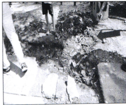
Fotos 5 y 6. Punto hasta donde llegan las aguas de escorrentías mediante el canal en tierra paralelo a la vía. En el tramo final se observa relleno y taponamiento del canal con material arenoso.
