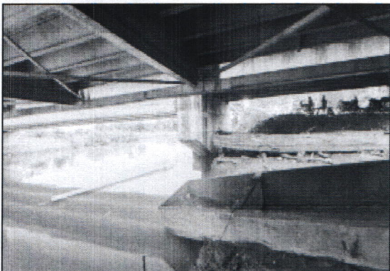
Imagen 3 y 4. Cauce del caño Aguas Prietas y estribo norte dentro del cauce del Caño Aguas Prietas disminuyendo la sección hidráulica, borde libre de aproximadamente 1m.
