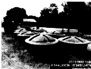
Foto 6. Tanques de sedimentación
