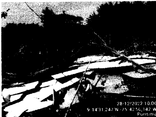
Foto 5. Disposición de residuos RCD en el sitio.
