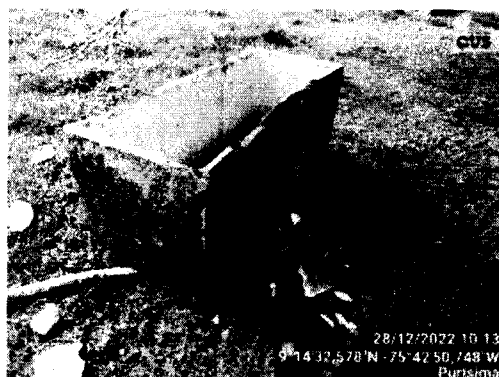
Foto 10. Disposición de residuos RCD en el sitio.
