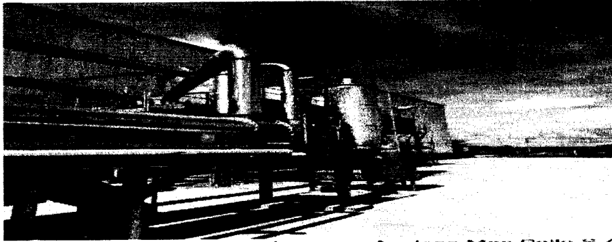
Fotografía 4. Chimeneas de gases Avides Mac Pollo S.A.
