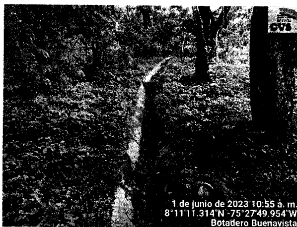
Foto 7. Canales perimetrales obstruido por sedimentos y vegetación.
