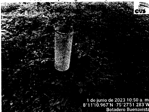
Foto 3. Chimenea de desfogue presente en el sitio.
