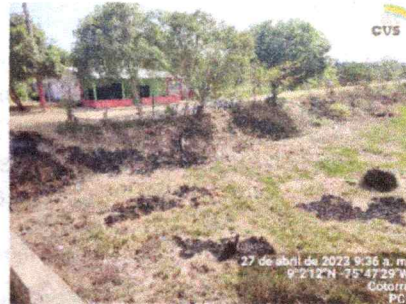
Foto 8. Presencia de incineración en el canal de drenaje #8.
