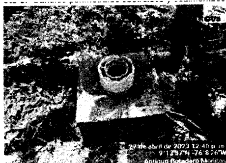
Foto 5. Piezómetro en mal estado.
