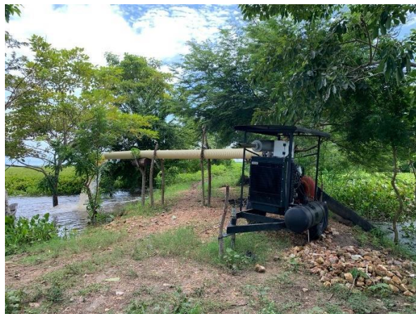
Foto 3. Motobomba trabajando en la evacuación del agua estancada en el corregimiento. Coordenada P2.
