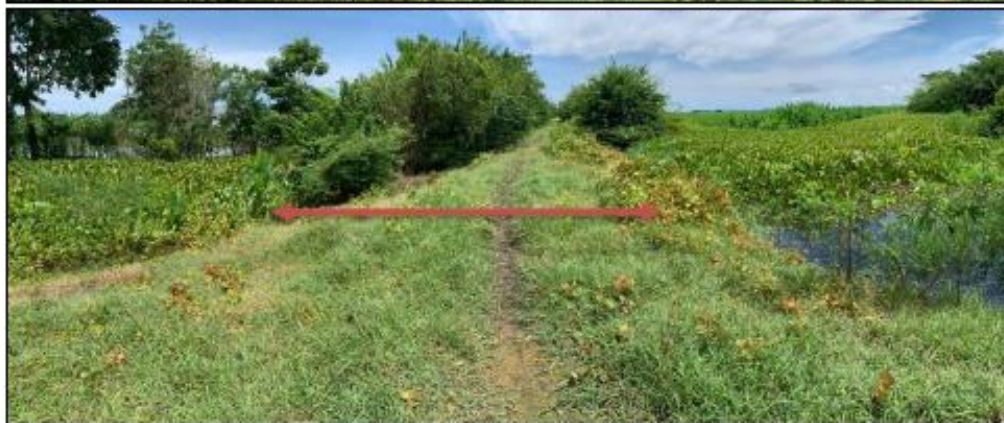
Foto 7 y 8. Se observan herbazales, vegetación arbórea y vegetación acuática propia de las zonas de humedal en ambos márgenes del terraplén.
