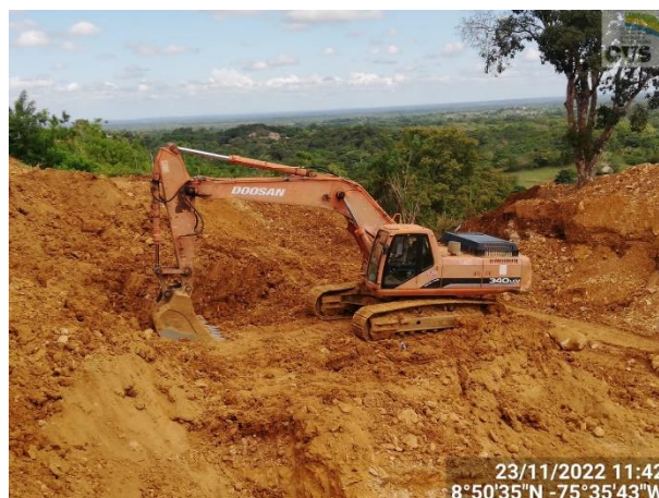
Foto 2. Retroexcavadora DOOSAN 340 LVC.
