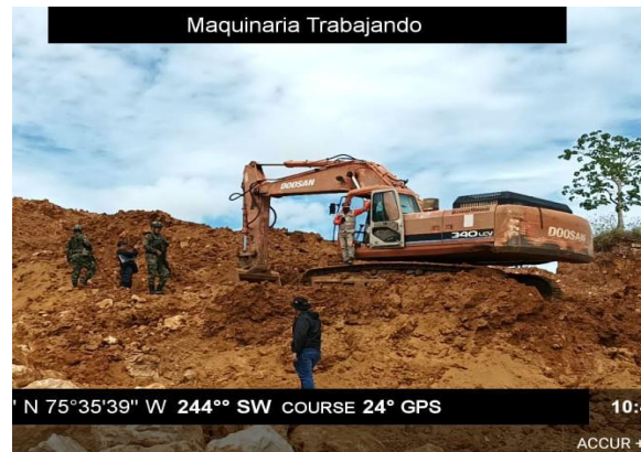
Foto 8. Retroexcavadora DOOSAN 340LCV
