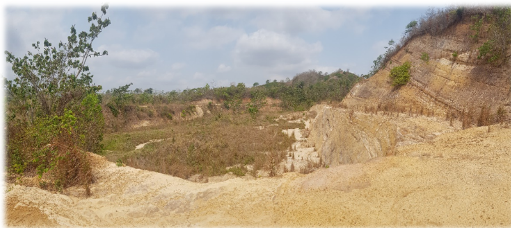
Celda de disposición principal
