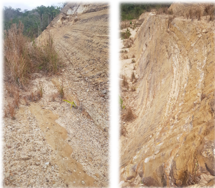
Estado actual de los taludes de la celda y del corte de terreno principal
