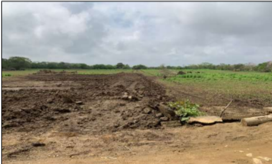
Foto N° 6. Fotografía remoción de material vegetal o descapote del terreno.
