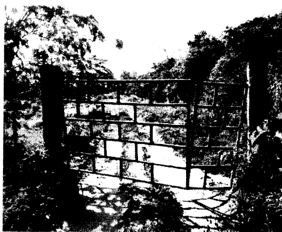
Foto 8. Entrada al predio del antiguo botadero.
