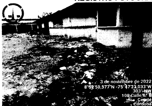
Foto 12. Aspecto general del sitio.
