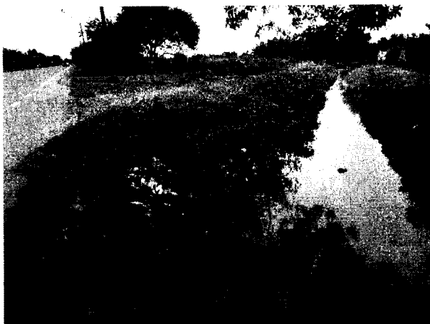
Foto 28. Aspecto general del sitio.
