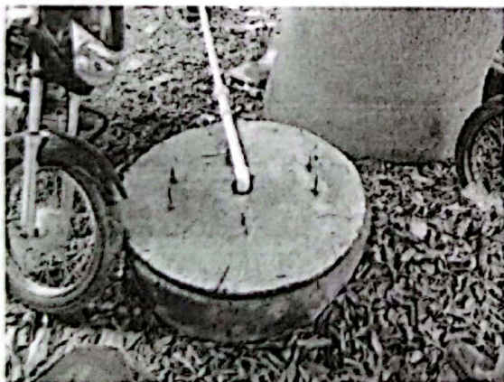
Fotografía. Sistema de captación del aljibe 2
