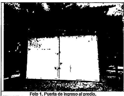
Foto 1. Puerta de ingreso al predio.
