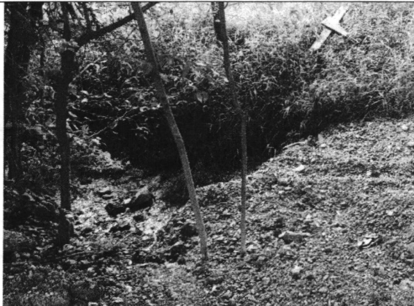
Foto 7. Vista de taponamiento evidenciado el 5 de julio de 2022
