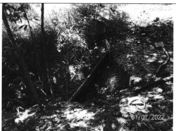
Foto 2. Vista cierre de cerramiento antes de la intervención
