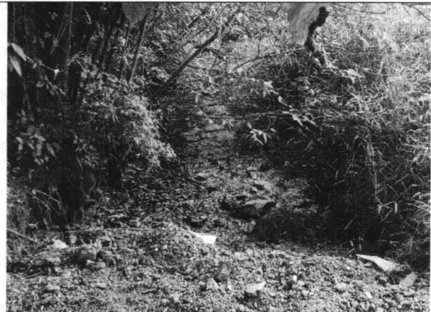
Foto 8. Vista de taponamiento evidenciado el 5 de julio de 2022
