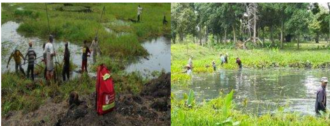
Limpieza del caño del Tigre en las inmediaciones de Garavito y Palo de Agua, realizado por las comunidades de Cotocá Arriba, Garavito, Palo de Agua y Castilleral
