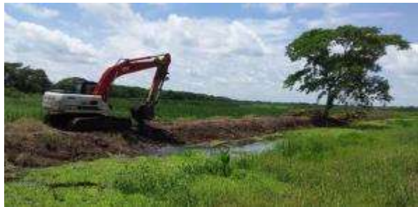
Destrucción de 59 secciones de terraplenes por parte de la maquinaria de la gobernación de Córdoba, como parte de la recuperación del humedal y cumplimiento del municipio de Cereté.
