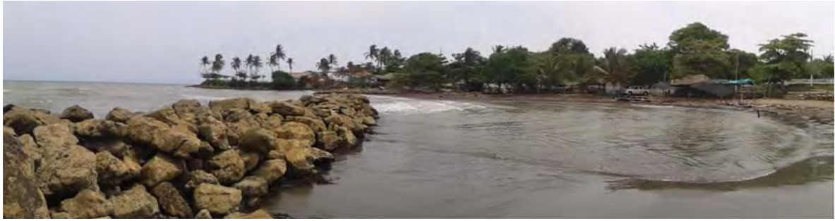
Rompeolas, enrocado y espolón en el sector Puerto Viejo
