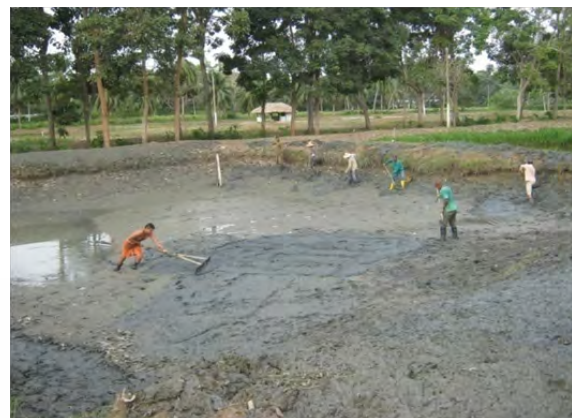
Foto 2.13 Adecuación de la infraestructura de la barcaza de estación piscícola de Lorica.
