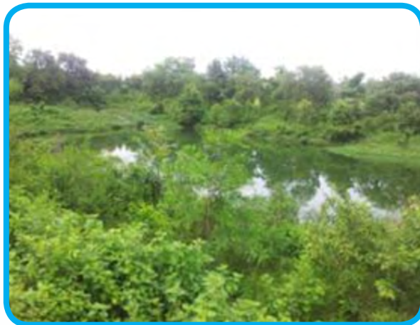
Foto 2.30 Laguna Estabilización primaria municipio de Canalete
