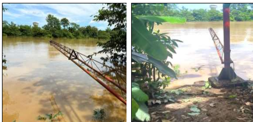
Figura. Estación SAT_CVS_019: Boca de La Ceiba, municipio Montería. Después del mantenimiento e instalación del sensor de nivel.
