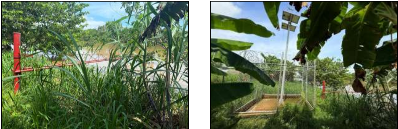
Figura.. Estación SAT_CVS_010: Estación Barrio La Pesquera, municipio de Montelíbano. Antes del mantenimiento.
