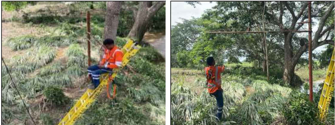
Figura.. Estación SAT_CVS_004: Estación Canalete, municipio de Canalete. Antes del mantenimiento.
