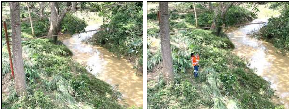
Figura 9.. Estación SAT_CVS_004: Estación Canalete, municipio de Canalete. Después del mantenimiento e instalación del sensor de nivel.
