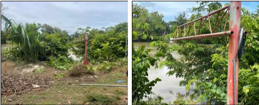
Figura. Estación SAT_CVS_012: Estación Cotocá Arriba, municipio de Santa Cruz de Llorica. Después del mantenimiento e instalación del sensor de nivel.
