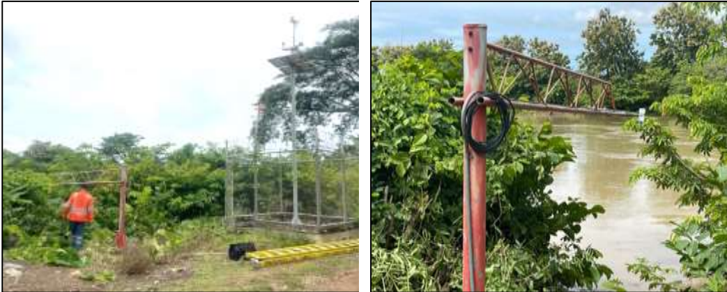
Figura. Estación SAT_CVS_012: Estación Cotocá Arriba, municipio de Santa Cruz de Llorica. Antes del mantenimiento.
