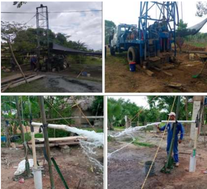
Realización de obras en sitio.
