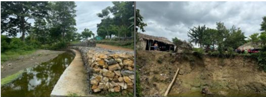
Arroyo Rabo Largo. Obra de mitigación para protección del Talud y erosión de aproximadamente 3 metros
