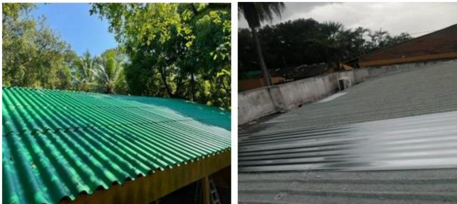
**Imagen 160.** Retiro e instalación de tejado de lámina galvanizada
