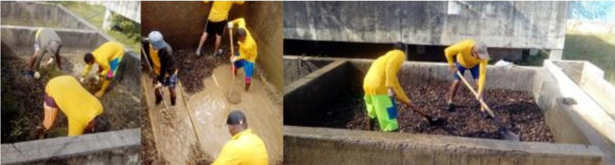
**Imagen 146.** Mantenimiento de filtros Estación piscícola Loricá.
