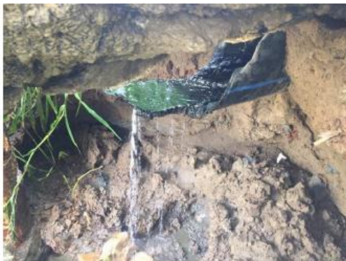
Foto N°3 y 4. Tubería de conducción del vertimiento al río Sinú.
