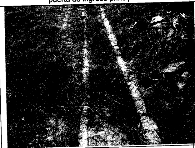
Fig. N° 3 Canales perimetrales obstruidos.
