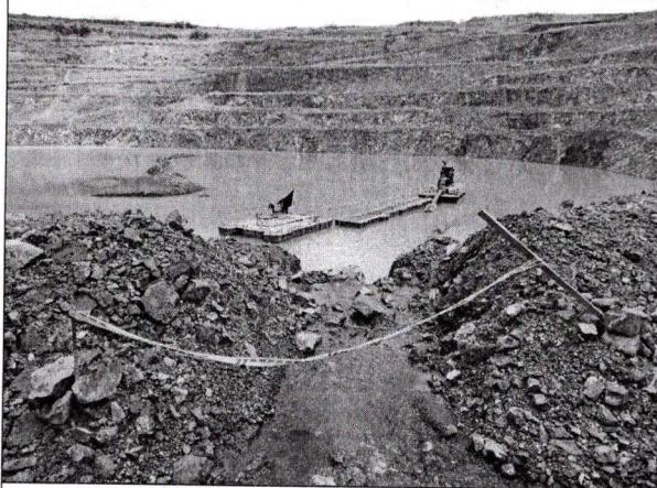
Fotografía No. 2. Vista de uno de los drenajes que por escorrentía aportan agua al PIT.
