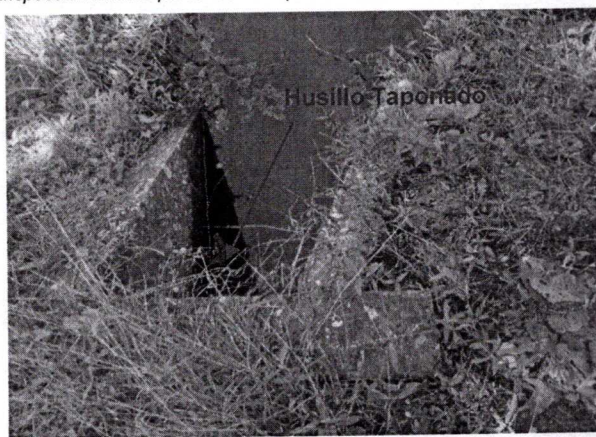
Fotografías 3 y 4. Estado Actual de Estructura hidráulica tipo husillo.
