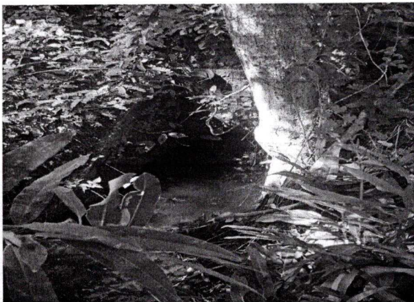
Fotografía 5. Taponamiento de husillo con trozos de madera y material vegetal.
