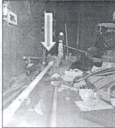
Foto No.4. Electrobomba instalada para la captación de agua subterránea.
