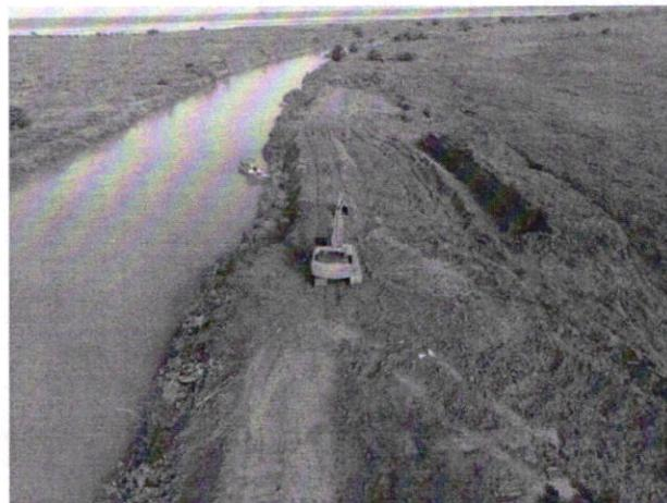
*Imagen 5 y 6. Maquinaria sin operario que ha estado trabajando en la construcción de terraplenes*
