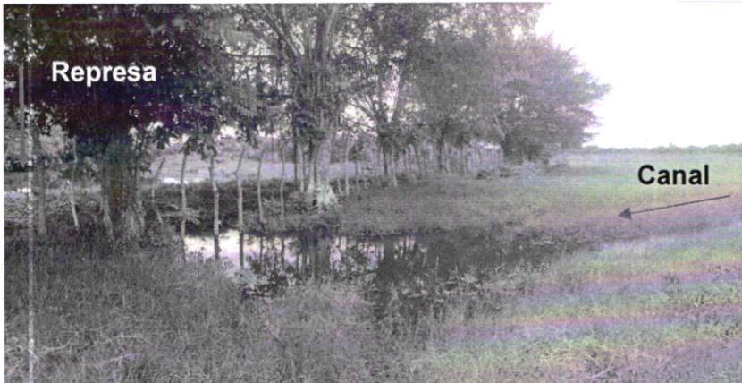
**Foto N° 2.** Se observa encharcamiento debido a que el canal construido al lado de la represa para transportar el agua del caño, y que recibe el canal mostrado, no tiene suficiente capacidad hidraulica.
