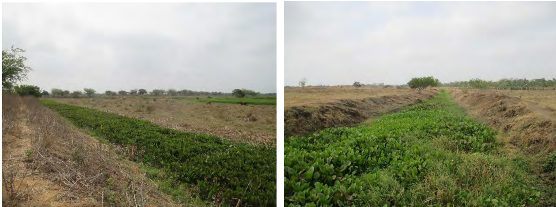
Figura 4. 1 Canales activos de arroyos, km 1+300 y 1+900.
