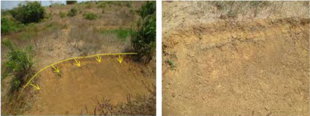
Figura 4. 12 Carcavamiento generado por erosión en suelos arenosos.
