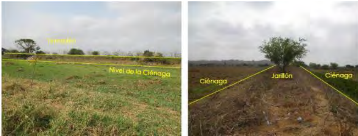
Figura 4. 10 Altura del terraplén respecto al terreno natural (izquierda). Jarillón en medio de Ciénaga (derecha).
