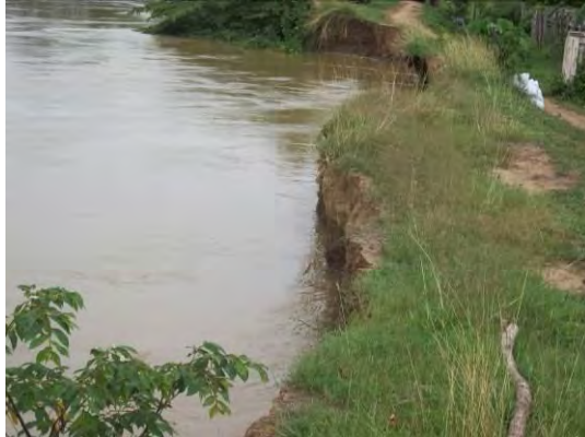
Ilustración 13. Puntos de erosión severa
